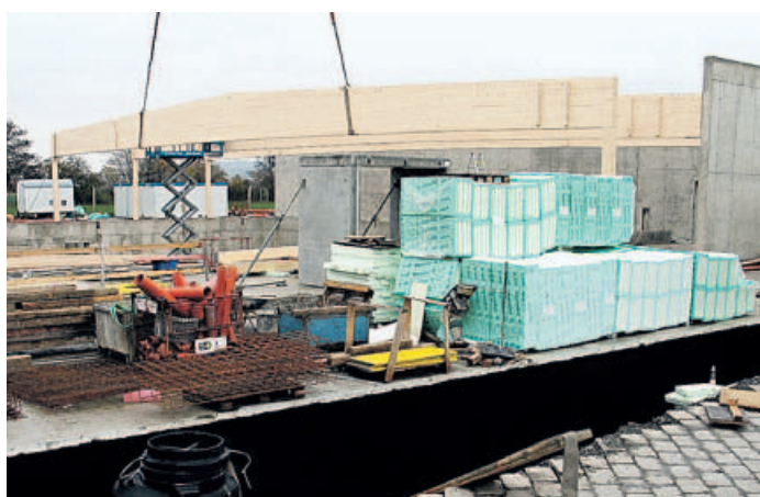
Am 10. November 2009 kamen die Holzleimbinder.
