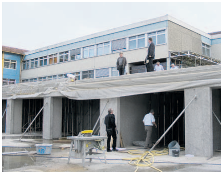
Nur als scheinbar grauer Einheitsbrei zeichnen sich auf der Großbaustelle im September 2009 die Tribüne (Mitte) und die Geräteräume (unten) ab, die Schule im Hintergrund erstrahlt nach ihrer energetischen Sanierung inzwischen in einem freundlichen Rotton.
