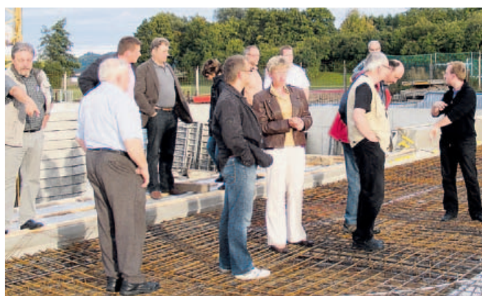
Während zahlreicher Ortstermine machten sich Stadträte und VG-Mitglieder ein Bild vom Baufortschritt.
