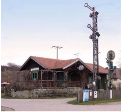
Alter Bahnhof Bockenfeld
