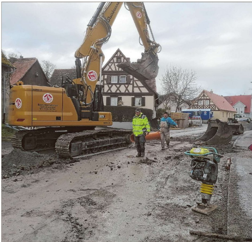
In der Rodgasse in Burgbernheim wird fleißig gewerkelt, bald geht es in der Erbsengasse weiter. Foto: Katrin Merklein
