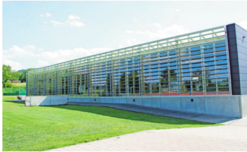
Beim Bau des Dachs der Turnhalle ist eine nachträgliche Installation einer PV-Anlage berücksichtigt worden. Archiv-Foto: Christine Berger
