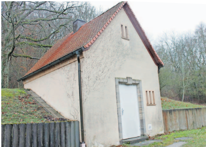
Eine Sanierung des Trinkwasserhochbehälters an der Steige wurde als unwirtschaftlich abgelehnt, deshalb soll im kommenden Jahr westlich des Gebäudes ein Neubau entstehen. Archiv-Foto: Christine Berger
