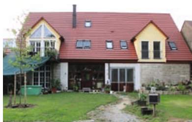
Weigenheim: Umbau einer Scheune zu einem Wohnhaus
