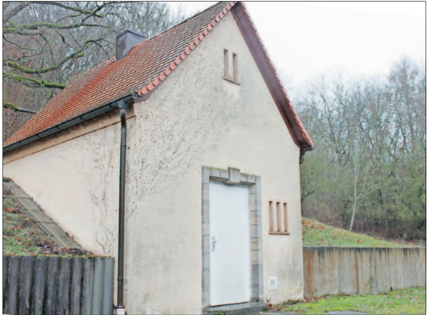
Aus dem Jahr 1960 stammt der Trinkwasserhochbehälter an der Steige, bei einem Neubau könnte die Stadt mit Fördermitteln rechnen. Foto: Christine Berger
