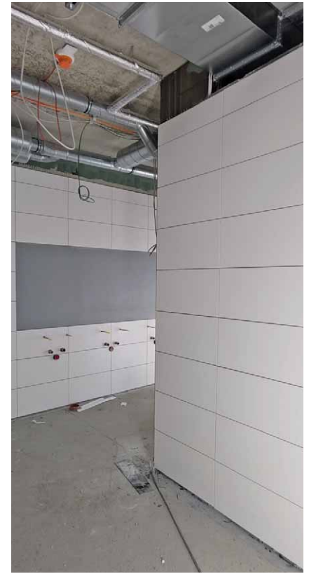
Fliesenarbeiten im WC-Bereich.
