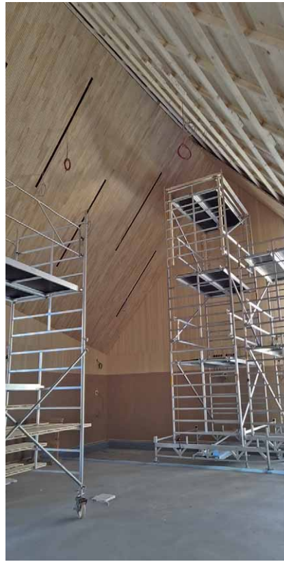
Holzverkleidung im Saal.
