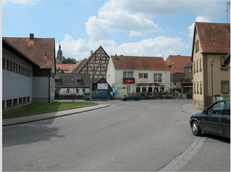
problematische Kreuzung Windsheimer Straße - Friedenseicheplatz
