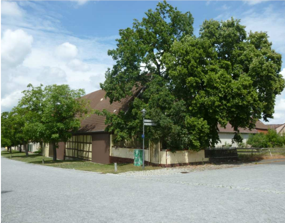
Untere Marktstraße/Untere Rathausgasse – Potentialfläche für z.B. Markthalle
