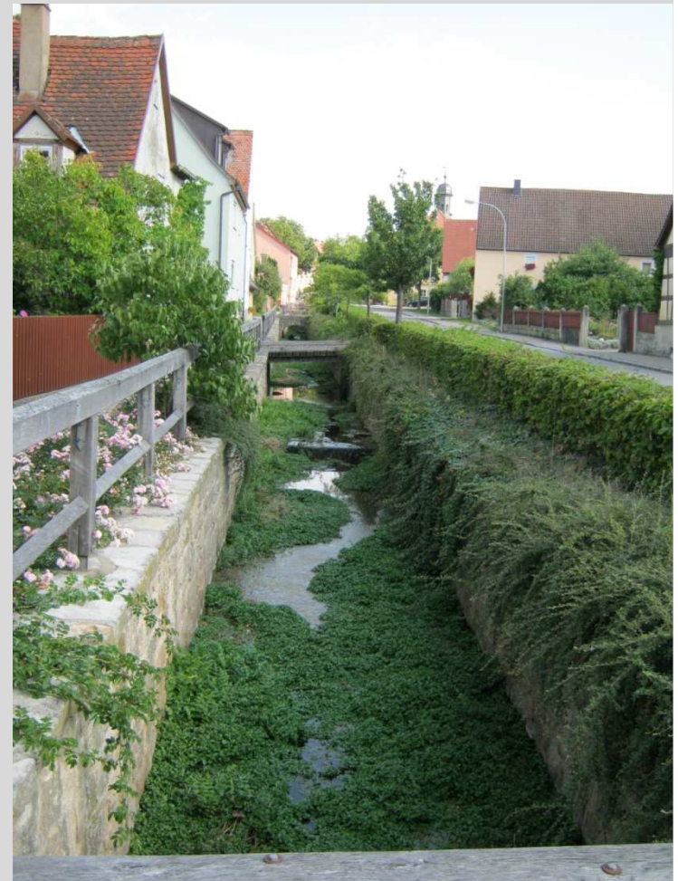
Rothenburger Straße – offener Bachlauf
