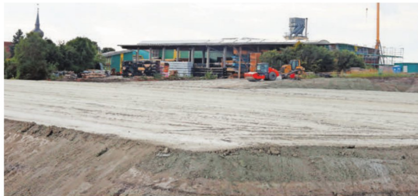
Neue Hallen sollen hier entstehen.
