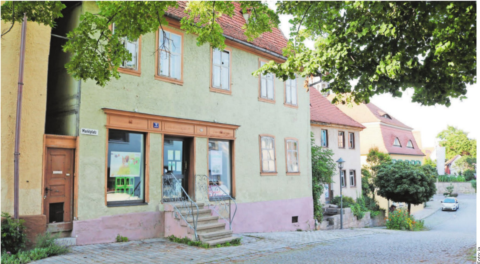
Zwei historische Gebäude – Weberanwesen und der frühere Schleckermarkt – sollen Teil des Streuobstkompetenzzentrums werden.
