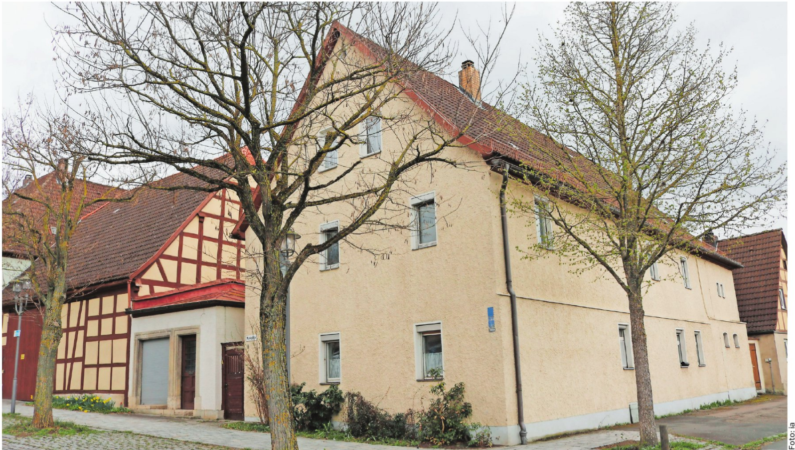
Der geplante Neubau wird sich in Details vom Vorgänger absetzen: So wird es moderne Dachgauben geben, bisher gibt es keine.
