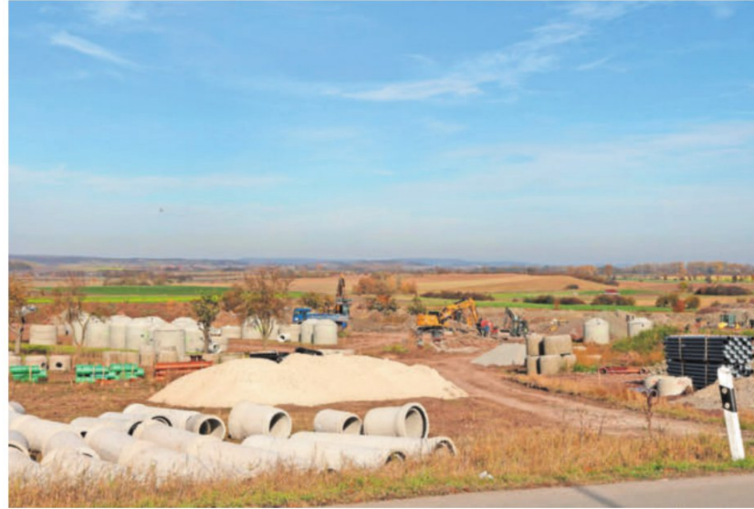
Im dritten Abschnitt des Baugebietes Gartenfeld-Ost werden derzeit Zisternen auf den Grundstücken versenkt. Foto: Claudia Lehner
